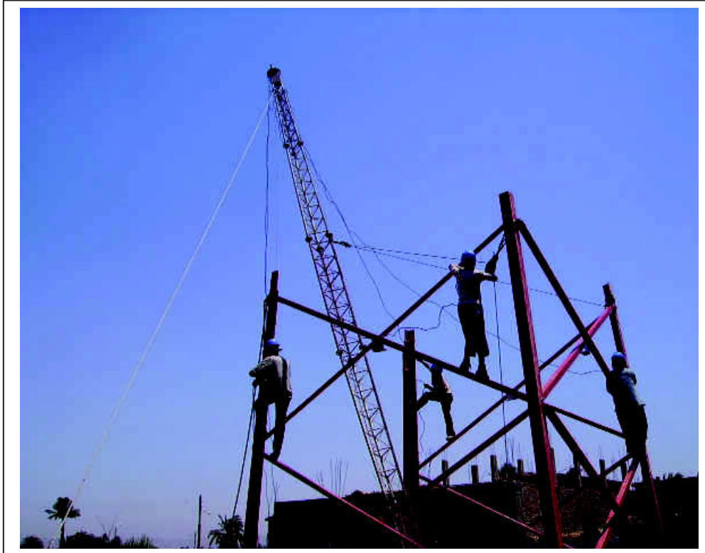
16) Tower Erection photo
