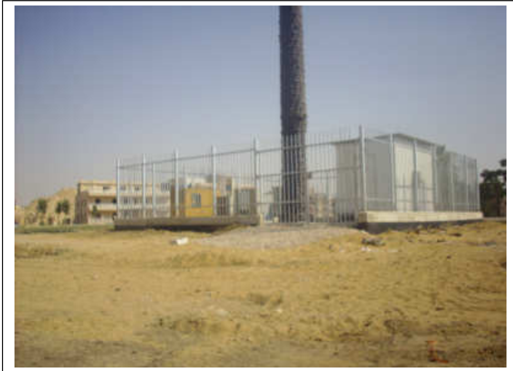
38) Site Leveling photo
