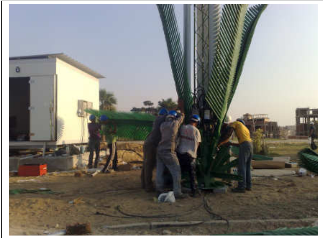
23) Palm Tree Erection photo
