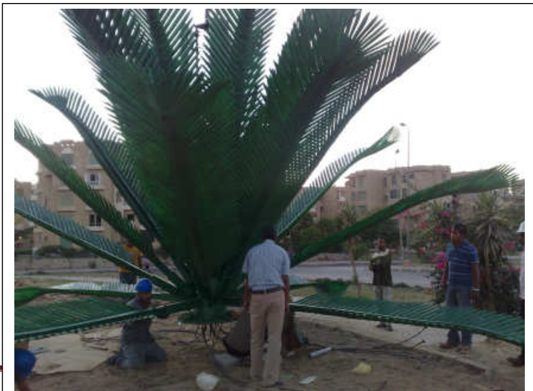
24) Palm Tree Erection photo
